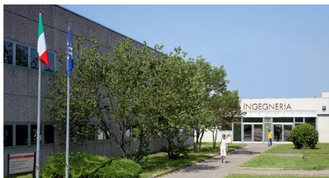
Ingresso della Sede Scientifica di Ingegneria
