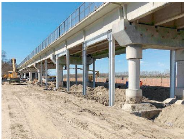
LAVORI IN CORSO La riapertura è prevista per il 5 giugno.
